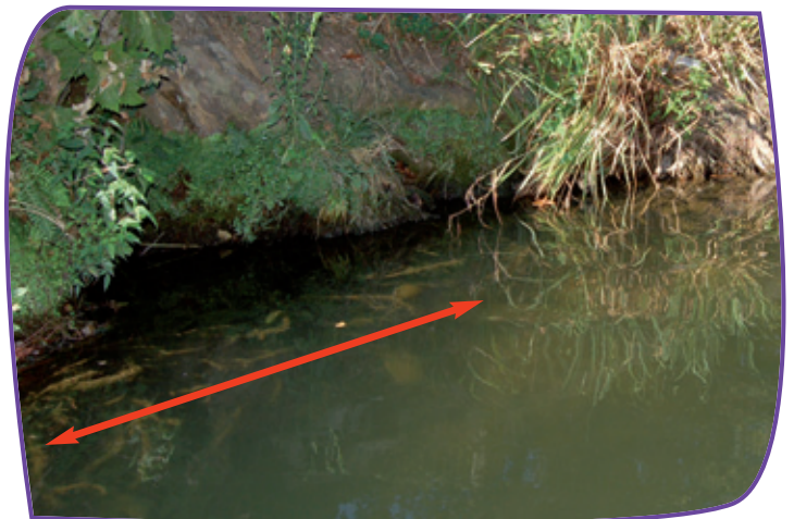
Berge sous cavée.
