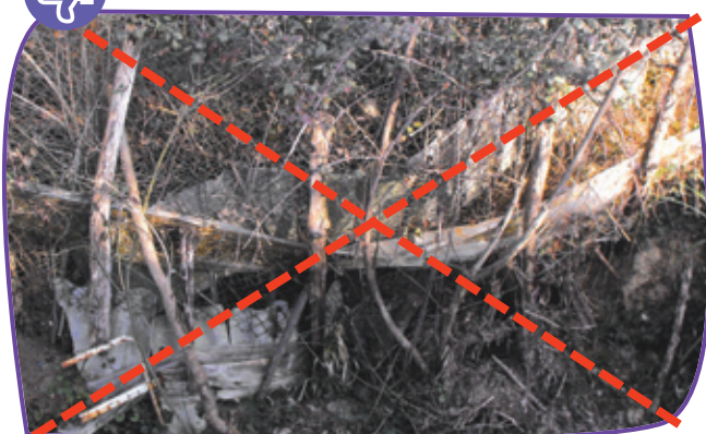
Protection de berge en matériaux inadaptés
