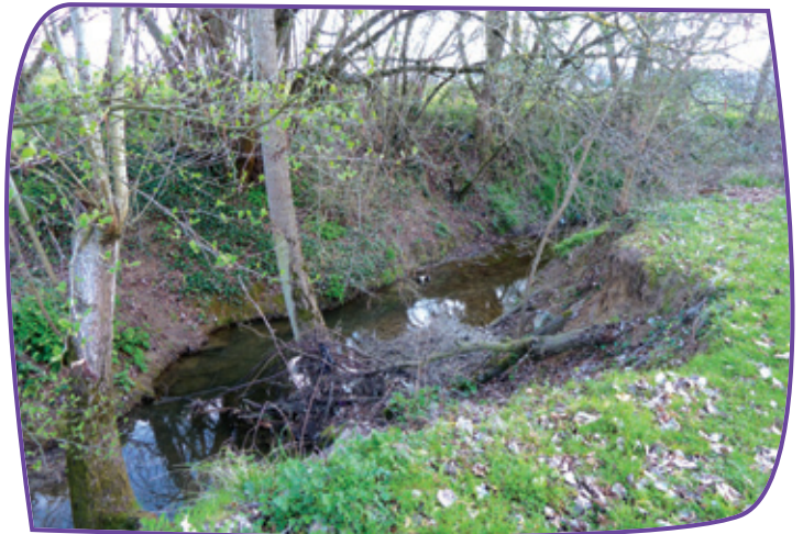
Erosion sur la berge : absence de végétation.
